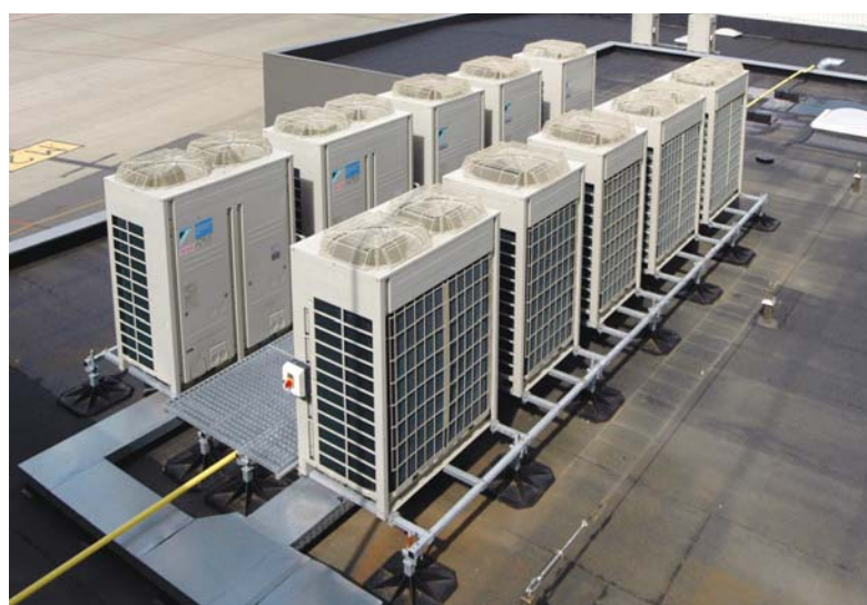
Rys. 3. Przykładowa realizacja w oparciu o serię wysokoelektywnych agregatów skraplających ZEAS o wydajności od 12,5 kW do 75,8 kW dla zastosowań średniotemperaturowych
