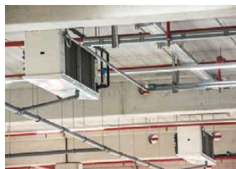
Rys. 4. Każdy system ZEAS jest podłączony do dwóch parowników
