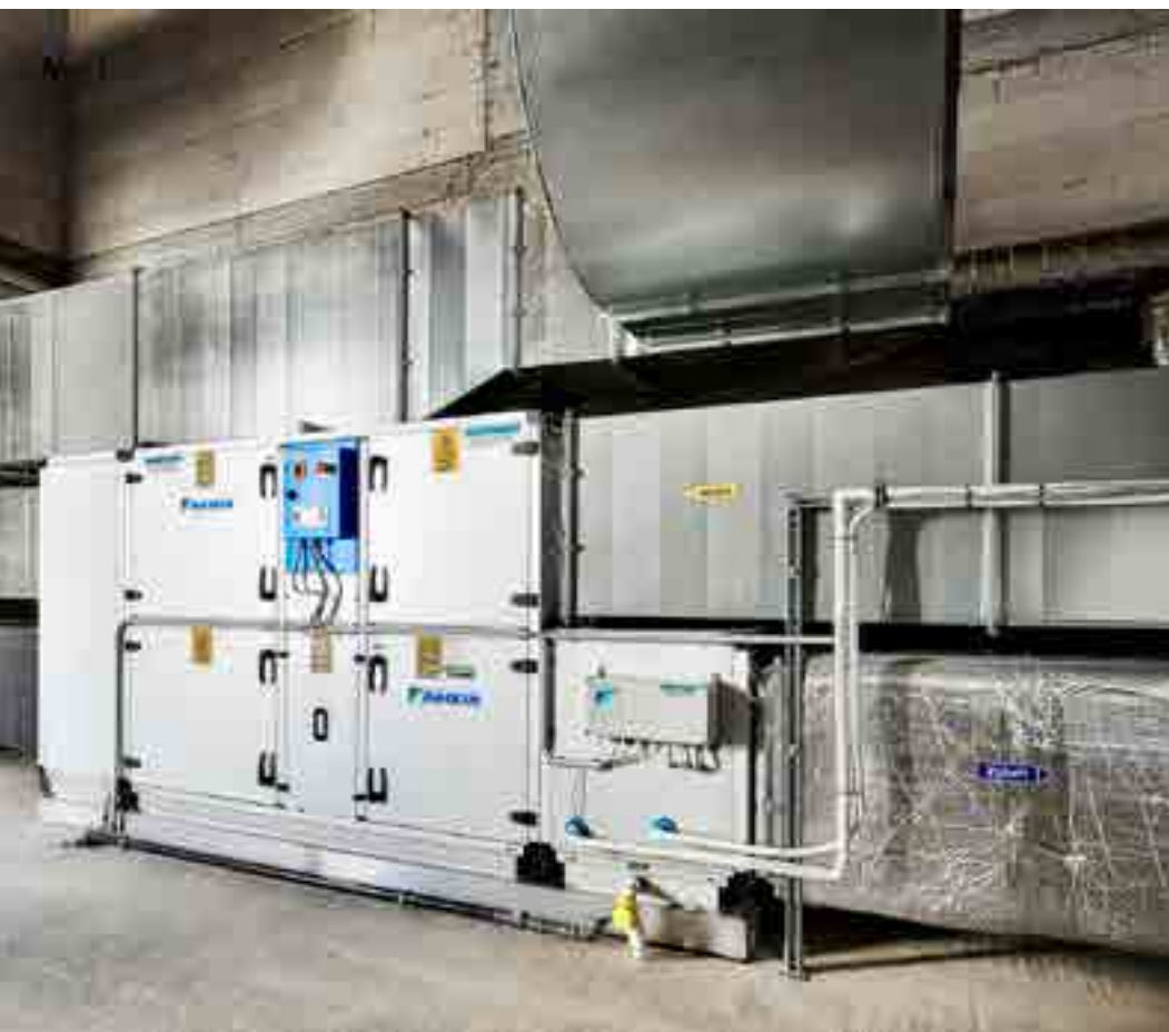
Instalacja D-AHU Modular R
