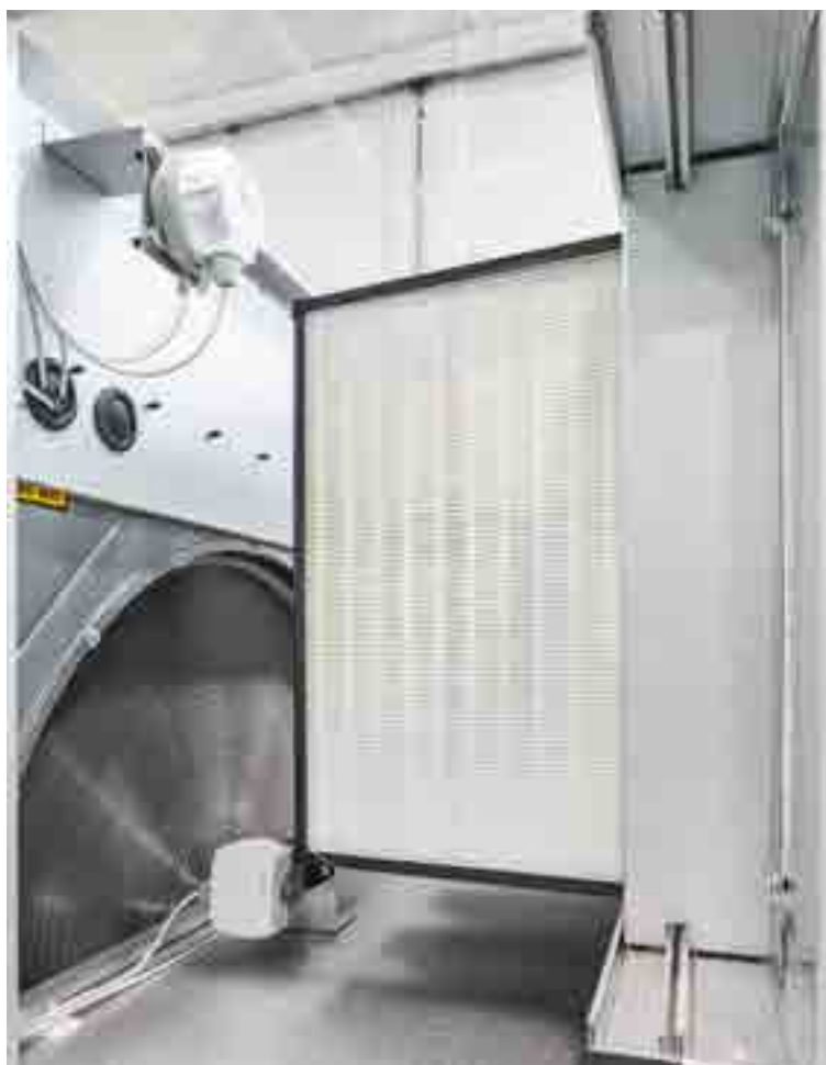
Wymiennik obrotowy i filtr
