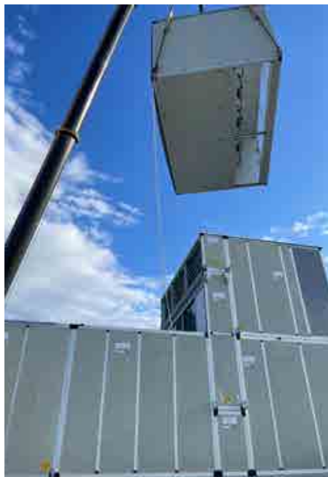
Profesjonalna instalacja D-AHU
